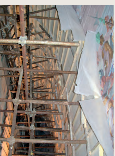
Puntellamento e applicazione della rete Amniflex. L'intonaco dell'intradosso è formato da un ariccio costituito da calce magnesiacca carbonatata e sabbia medio/fine di 15/20 mm circa e da un intonachino costituito da calce magnesiacca e sabbia fine di 5/6 mm. Le ricerche e le indagini conoscitive hanno fornito i dati per individuare le zone d'intervento.
