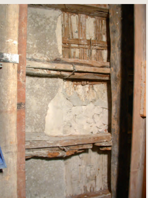
Il canniccio e gli strati sovrannessi, croili e crepe. La stuola in canniccio è costituito dall'incrocio di fasci di 4 canne tagliate a metà ed è vincolata alle centine dalla parte dell'intradosso mediante chiofi in ferro. Le misure medie delle singole canne sono: larghezza circa 18/20mm, spessore 3/4mm. La decorazione pittorica è stata realizzata con la tecnica del buon fresco.
