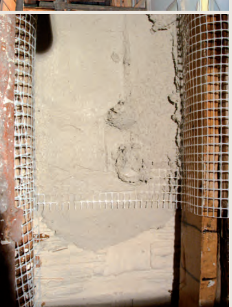
Puntellamento e applicazione della rete Amniflex. L'intonaco dell'intradosso è formato da un ariccio costituito da calce magnesiacca carbonatata e sabbia medio/fine di 15/20 mm circa e da un intonachino costituito da calce magnesiacca e sabbia fine di 5/6 mm. Le ricerche e le indagini conoscitive hanno fornito i dati per individuare le zone d'intervento.
