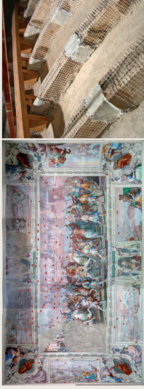
Rilievo delle placchette di sostegno del restauro del '46 e l'estradosso dopo il consolidamento. Le centine lignee a forma di volta a padiglione sono disposte con un interasse medio di 35/40 cm e di spessore variabile tra i 7/8 cm. Sono ottenute mediante la connessione di pezzi corfi di due tavole affiancate e sagomate, unite tra loro da chiodi ribattuti.
