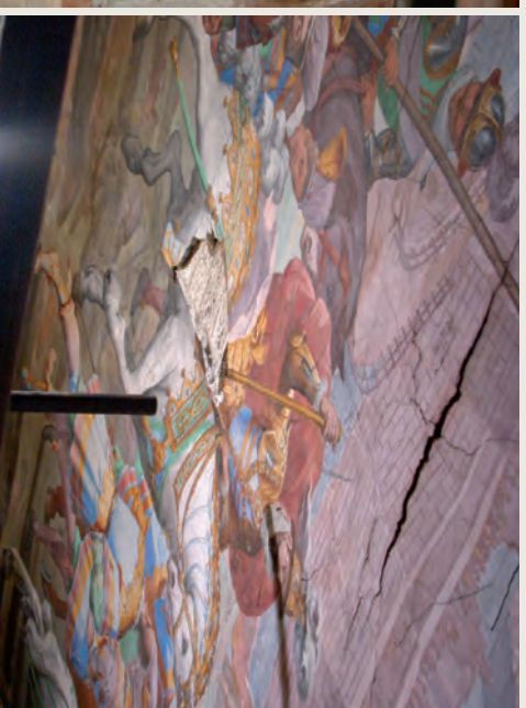
Il canniccio e gli strati sovrannessi, croili e crepe. La stuola in canniccio è costituito dall'incrocio di fasci di 4 canne tagliate a metà ed è vincolata alle centine dalla parte dell'intradosso mediante chiofi in ferro. Le misure medie delle singole canne sono: larghezza circa 18/20mm, spessore 3/4mm. La decorazione pittorica è stata realizzata con la tecnica del buon fresco.
