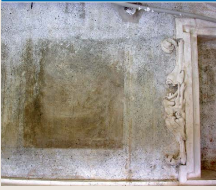
La tinteggiatura pittorica sulle decorazioni cinquecentesche, è stata realizzata con colori all'acquario e a calce legati con resina acrilica in opportuna diluizione.
