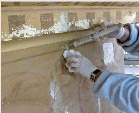
Consolidamento della striscia decorata e prove di colore. Le piccole lesioni superficiali sono state stuccate con grassello di calce stagionato e iniezione di apposite resine e leganti speciali.
