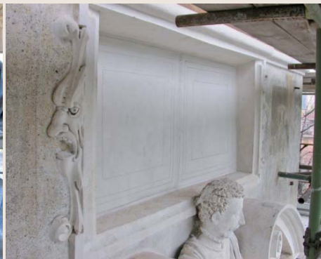
Consolidamento della striscia decorata e prove di colore. Le piccole lesioni superficiali sono state stuccate con grassello di calce stagionato e iniezione di apposite resine e leganti speciali.
