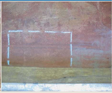
La tinteggiatura pittorica sulle decorazioni cinquecentesche, è stata realizzata con colori all'acquario e a calce legati con resina acrilica in opportuna diluizione.
