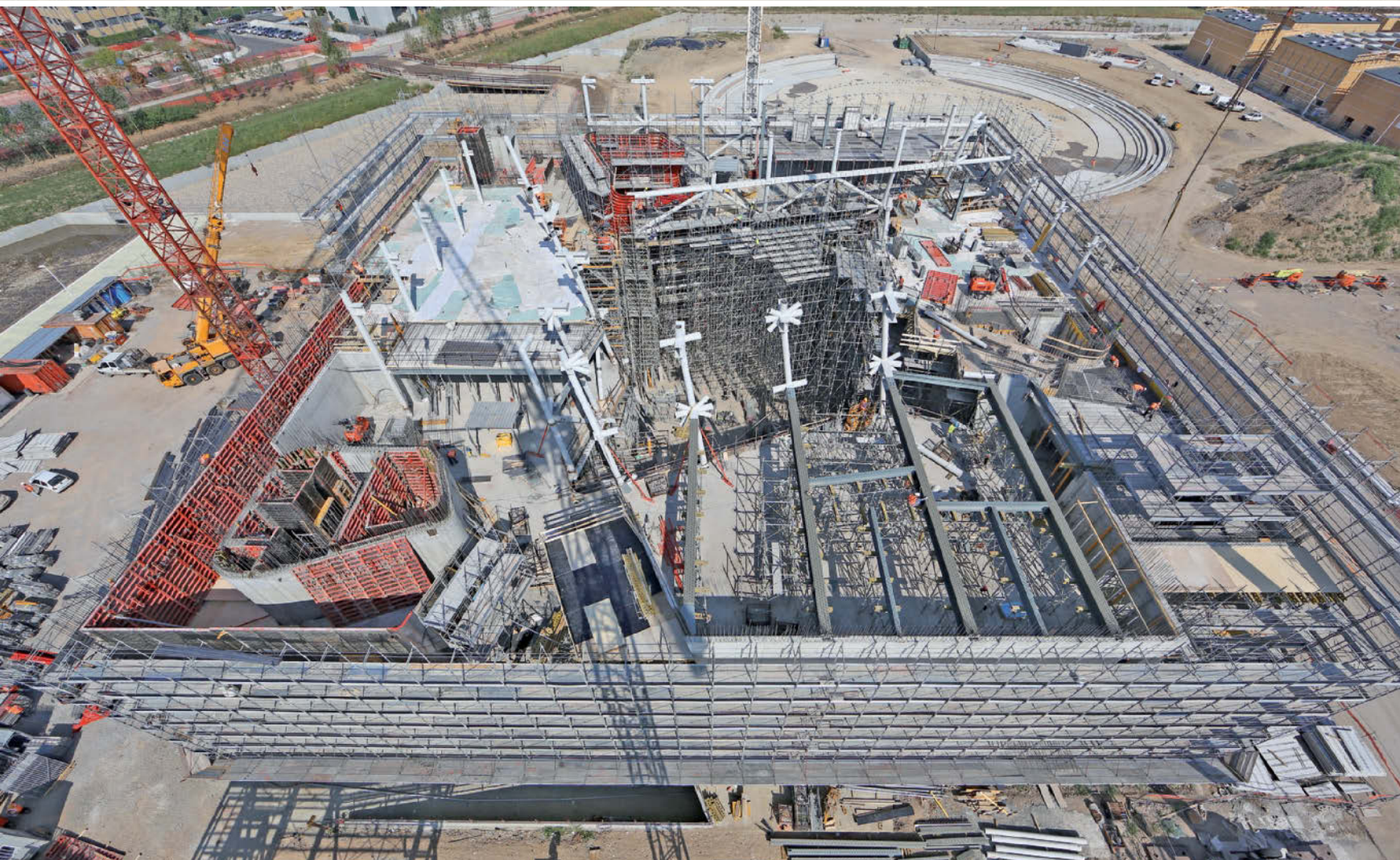
LA REALIZZAZIONE di Palazzo Italia ha comportato uno studio molto dettagliato di tutte le fasi di assemblaggio: mentre alcune facciate risultavano quasi complete, in altre parti del padiglione vi era la presenza dei ponteggi per il posizionamento degli agganci delle pannellature.
