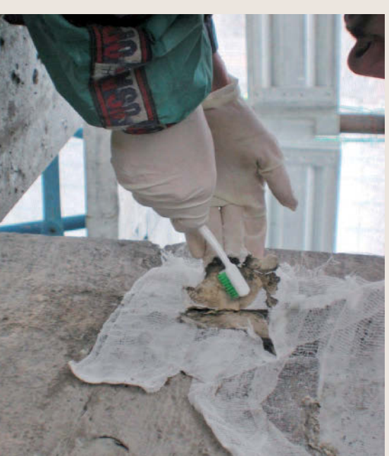
Sul lanternino della Cappella Alberti è stato eseguito un consolidamento a impacco con tempi di applicazione molto lunghi. L'impacco era alimentato a un sistema a caduta tipo flebo, in modo da consentire una lenta e continua impregnazione della pietra anche nelle parti più interne. I tempi di applicazione oscillavano da 16 a 32 ore.
