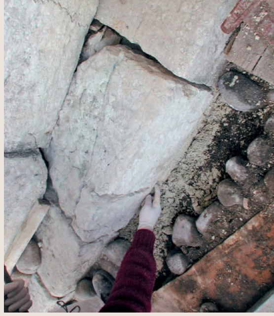
Nelle aree dove le scagliature erano più evidenti, sono stati identificati anche fenomeni di rigonfiamento e polverizzazione che interessavano la parte più superficiale dei conci. Meno diffusa era, invece, la presenza di croste nere localmente queste presentavano una struttura dendritica, circoscritta a zone non sottoposte a dilavamento meteorico.
