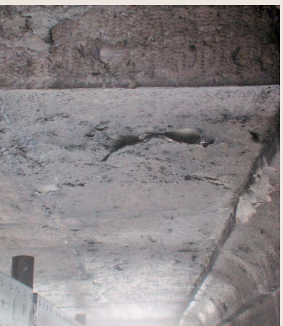
Là dove il materiale era particolarmente decesso fino a polverizzazione o esfoliazione intensa, si è proceduto al consolidamento con silicato di etile applicato in due mani con pennello, seguendo dei movimenti a tampone, bagnando in maniera adeguata la superficie.
