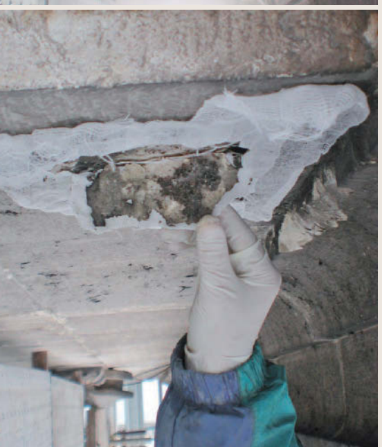
Là dove il materiale era particolarmente decesso fino a polverizzazione o esfoliazione intensa, si è proceduto al consolidamento con silicato di etile applicato in due mani con pennello, seguendo dei movimenti a tampone, bagnando in maniera adeguata la superficie.
