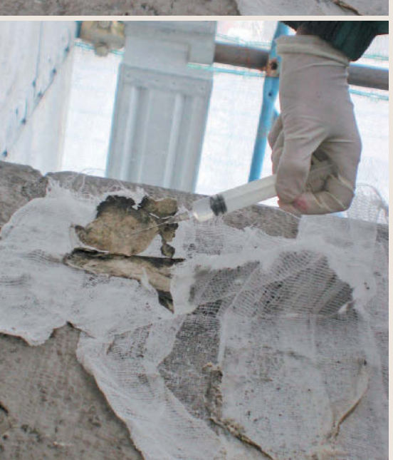
Sul lanternino della Cappella Alberti è stato eseguito un consolidamento a impacco con tempi di applicazione molto lunghi. L'impacco era alimentato a un sistema a caduta tipo flebo, in modo da consentire una lenta e continua impregnazione della pietra anche nelle parti più interne. I tempi di applicazione oscillavano da 16 a 32 ore.
